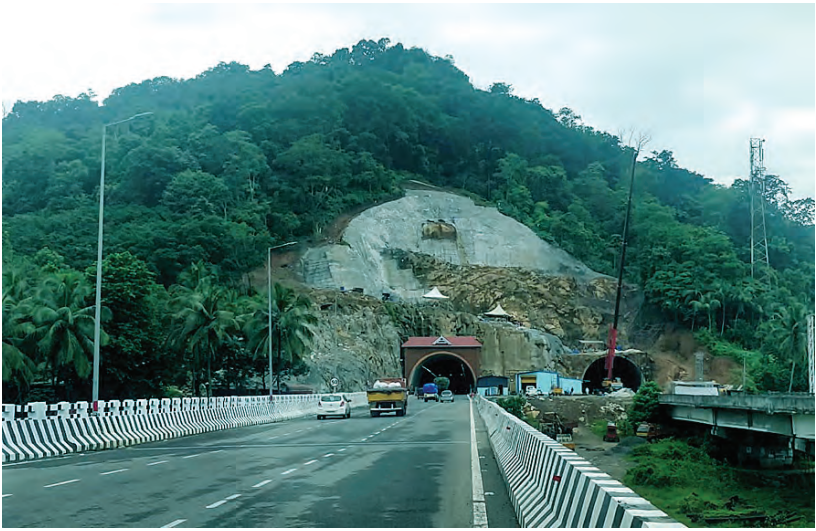
920కోట్లతో కొండను తొలచి సొరంగ మార్గం చేస్తారేమో
